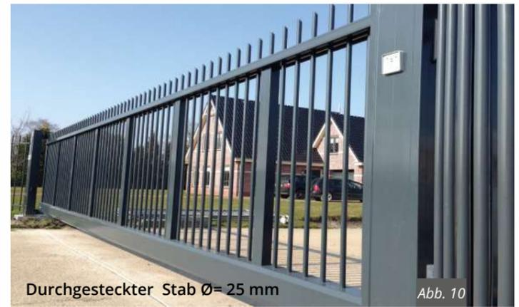
Durchgesteckter Stab Ø= 25 mm
